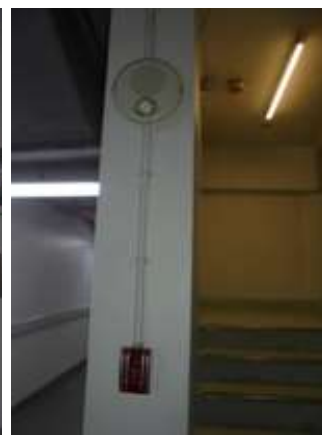
ลิฟต์ดับเพลิง เครื่องส่งสัญญาณโดยใช่มือดึง ภาพที่ 3-14 อุปกรณ์ป้องกันและเตือนอัคคีภัย
