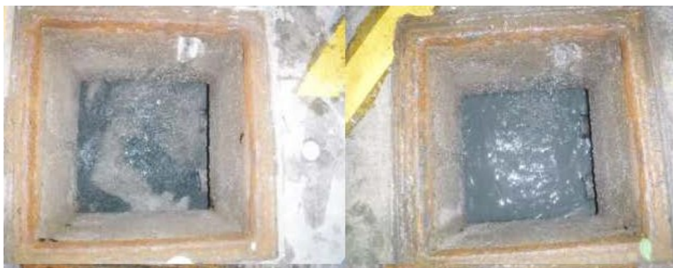
สูบล้างปลวกออกจากบ่อดักไขมัน และเติมสารชีวภาพในบ่อดักไขมัน ภาพที่ 3-27 ดูตะกอนไขมันและตะกอนในบ่อเก็บตะกอนของระบบบำบัดน้ำเสีย
