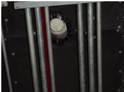
เครื่องตรวจจับความร้อนในห้องเครื่องกำเนิดไฟฟ้าฉุกเฉิน และเครื่องตรวจจับควันในโถงรับรองแขก
