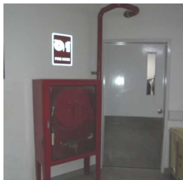
ตู้เก็บสายฉีดน้ำดับเพลิงพร้อมอุปกรณ์ ระบบท่อเย็น และกริ่งสัญญาณเตือนอัคคีภัย
