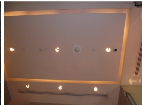
เครื่องตรวจจับความร้อนในห้องเครื่องกำเนิดไฟฟ้าฉุกเฉิน และเครื่องตรวจจับควันในโถงรับรองแขก
